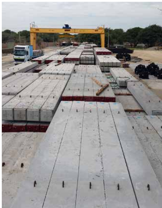
Fabricación de pilotes.
